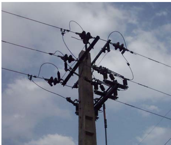
شکل ۶-۱ - در این شکل سکسیونر مانوری شبکه دیده میشود [۱۴].
