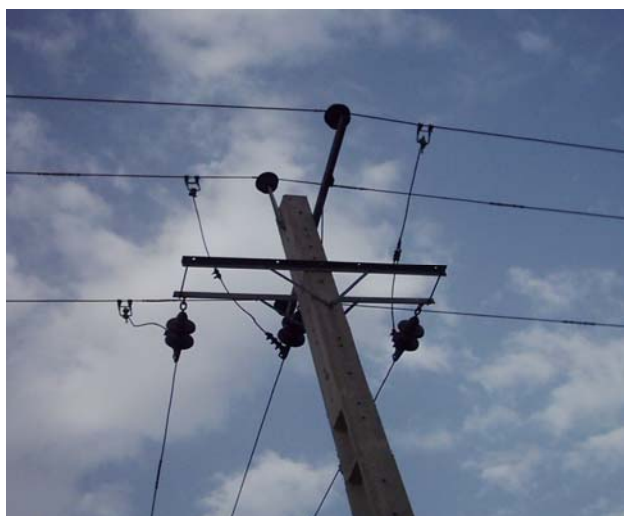
شکل ۶-۲ - در این شکل استفاده از کلمپ و رکاب خط گرم در سرخط شبکه ۲۰ کیلوولت جهت بازوبست در مواقع نیاز را نشان میدهد [۱۴].
