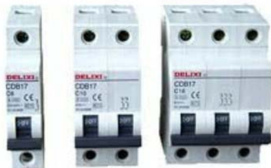
شکل (۵-۴). نمایی از یک کلید مینیاتوری
